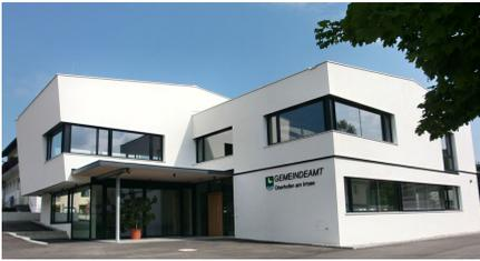
**Bauweise:** Zweigeschossiger in den Hang gebauter Holzriegelbau. Das Untergeschoss ist in Massivbauweise ausgeführt.
