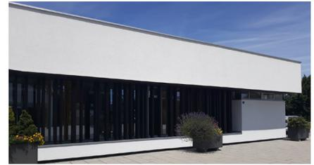
**Bauweise:** Zweigeschossiger in den Hang gebauter Holzriegelbau. Das Untergeschoss ist in Massivbauweise ausgeführt.
