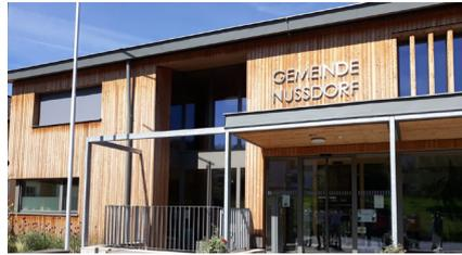
**Bauweise:** Dreigeschossig in Vollholzbauweise. Unterkellerung und Liftschacht in Massivbauweise.
